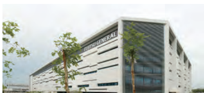
Centrum badawczo-rozwojowe w Fujitsu General Engineering (Tajlandia)
